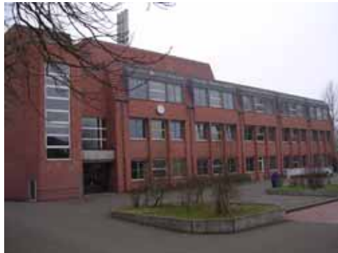
Der Neubau der Johann-Heinrich-Pestalozzi-Schule
