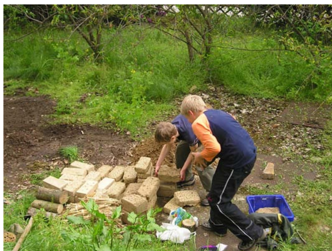
Lehmziegelherstellung und -verlegung durch die Schüler/innen
